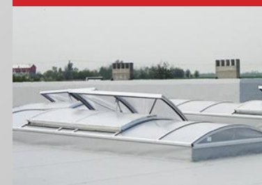
Rekonštrukcie strešných svetlíkov
