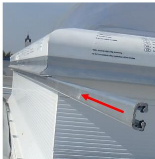
Rys. 19. Nasuwanie łącznika.
