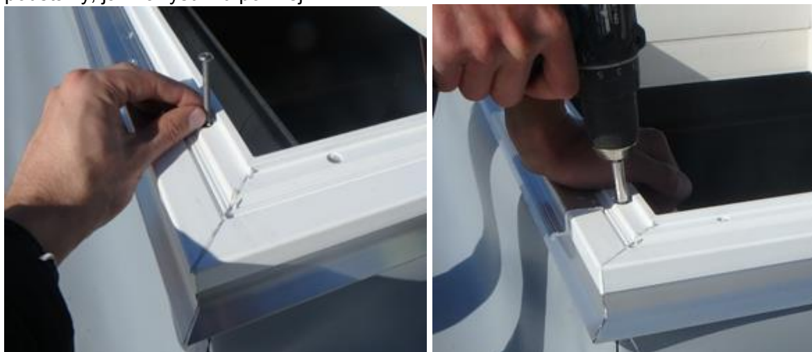
Rys. 11. Przymocowanie wieńca PVC do podstawy metalowej.
