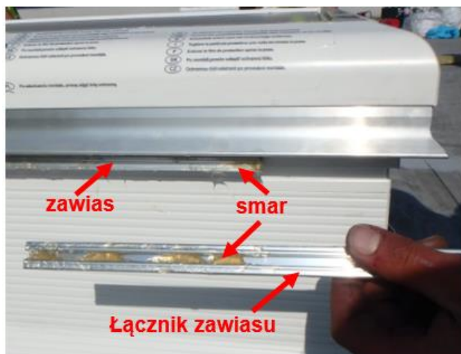
Rys. 18. Smarowanie zawiasu.
