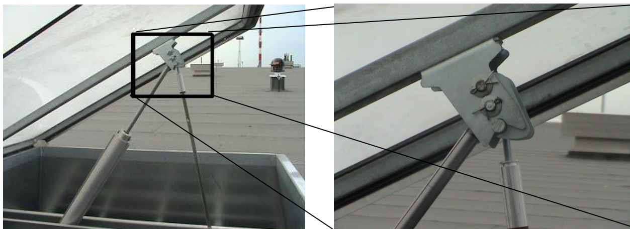
Rys. 28. Połączenie siłowników z konsolą hakową.
