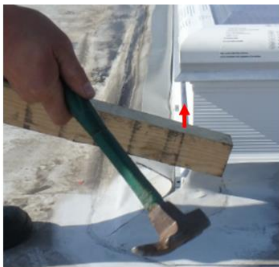
Rys. 20. Nabijanie łącznika.
