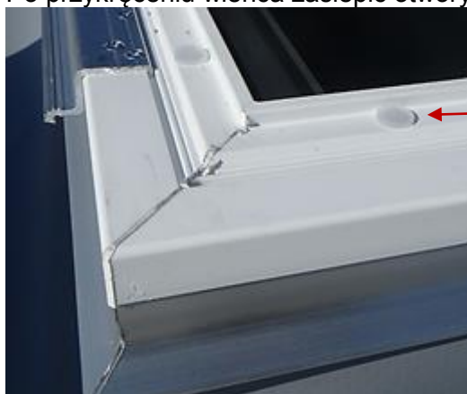
Rys. 12. Montaż zaślepek w wieńcu PVC.
