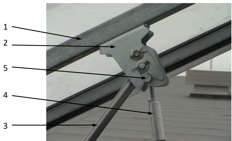
Rys. 21 Konsola hakowa.
